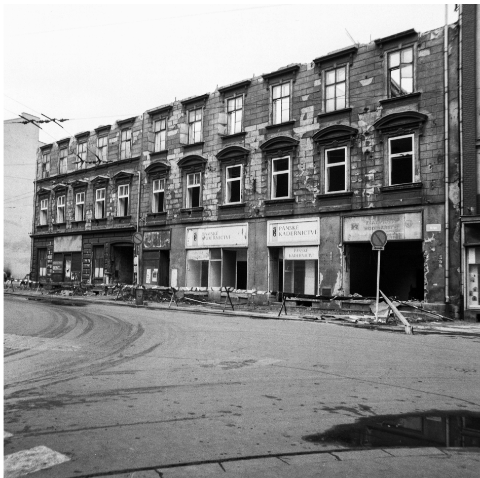
85 – Ostrava, budova, v níž sídlilo Uměleckoprůmyslového muzeum Ostravsko-karvinského revíru, dokumentární snímek z průběhu demolice objektu, počátek devadesátých let 20. století © Archiv města Ostravy.
