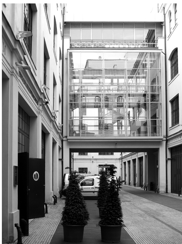
113 – Vídeň, Hofmobiliendepot, vestavba komunikační chodby mezi křídla budovy, současný stav.
